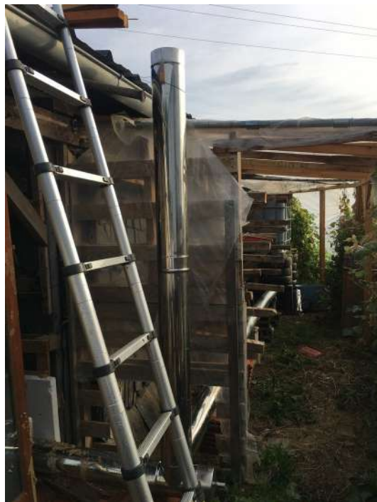
8. Sortie : La cheminée doit toujours être plus haute que le faîte du toit parce que si les gaz de sorties sont plus froid que la température extérieure, l'air va tirer vers le bas et non vers le haut.
